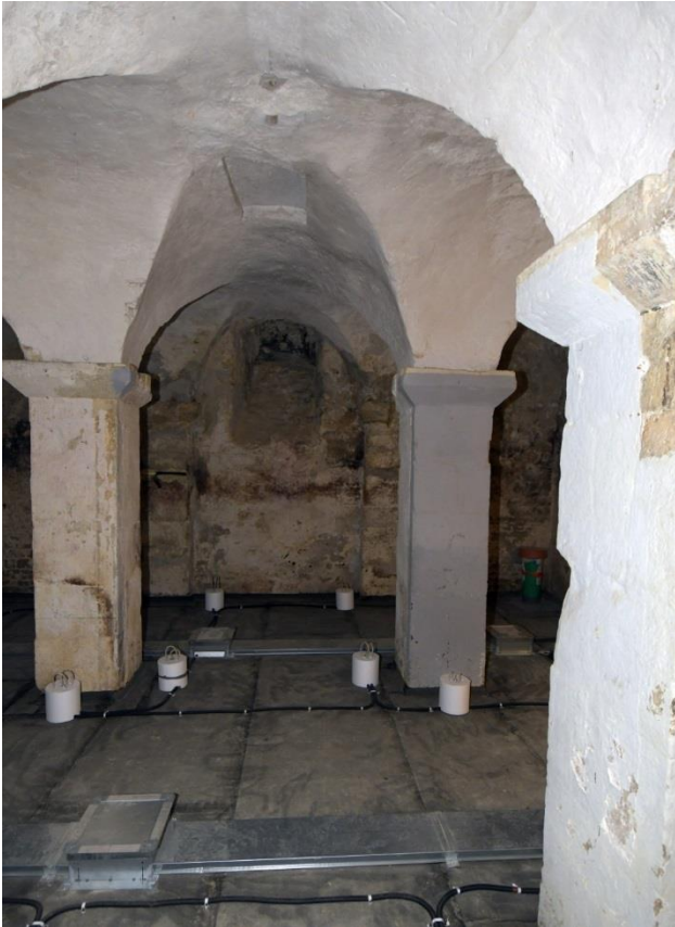
Goslar, Rathaus, Südwestflügel. Kellergeschoss, Blick nach Westen. Neunfeldriger quadratischer Grundriss mit Pfeilern und Kreuzgratgewölbe. Foto: Eißing 2020
