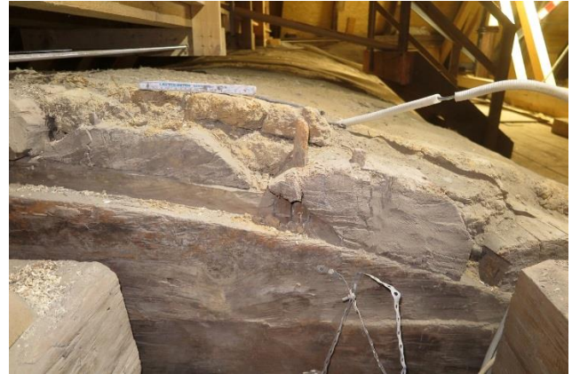
Goslar, Rathaus. Ratsstube, Deckenkonstruktion. Blick nach Westen. Östliche Bohlenwand und mit dieser verkämmte und verdollte Deckenbohlen. Zur Dämmung sind Lehm-packungen aufgebracht. Foto: Eißing 2019
