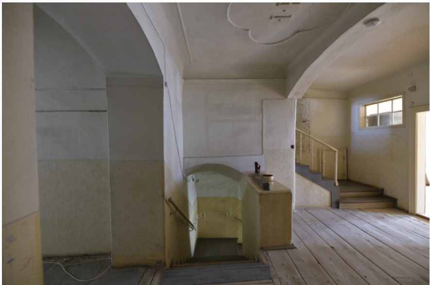
Gmünd in Kärnten, Hauptplatz 25, sog. Laxhaus (Kernbau um 1305d). Blick in den Flur und das Treppenhaus im 1. Obergeschoss. Foto: Thomas Eißing 2023
