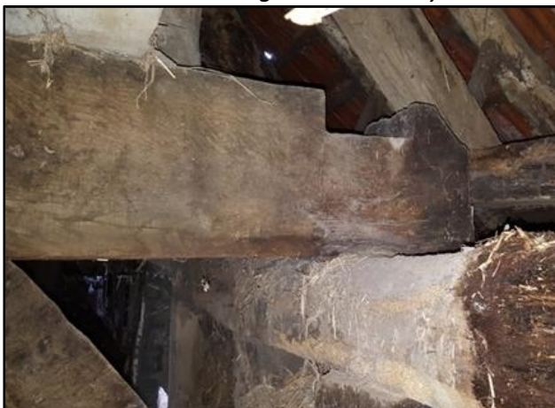
Abb. 2: Luchtbalken mit Knagge und Abfasung mit Fasenstopp, um 1600 (d).
